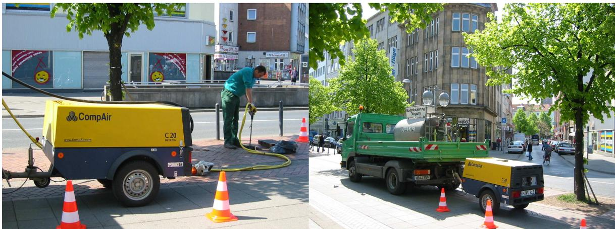
Ahnliche Techniken, wie z. B. **Treelife** oder **Terra lift** können ebenfalls für die Ausbringung genutzt werden. Gleichzeitig wird der Wurzelbereich bewässert und langfristig gedüngt. Das Wurzelwachstum wird sichtbar verbessert, die Sauerstoffproduktion der Bäume und Sträucher erhöht und die schädliche Bodenverdichtung langjährig beseitigt.
